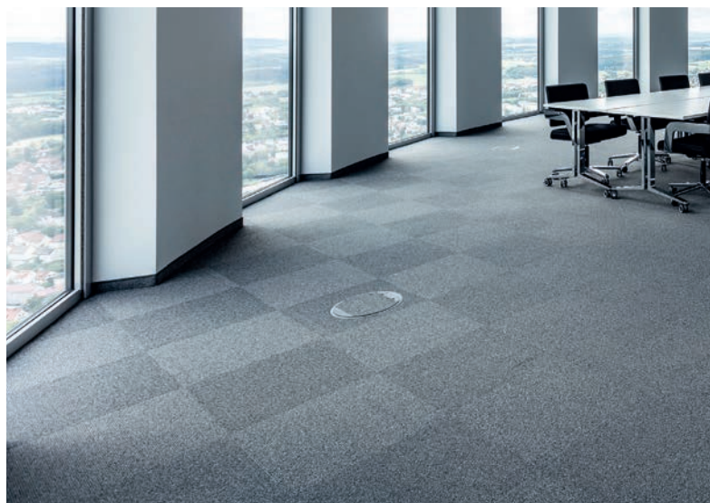
Saubere Lösung, auch bei rundem Grundriss: Den Wandanschluss in den Konferenzräumen bilden gekettelte Teppichsockelleisten, an den bodentiefen Fenstern kam ein passgenauer Anchnitt zum Einsatz.
