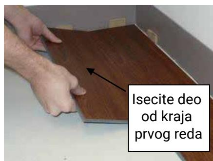
6. Postavite dužu stranu prve daske drugog reda. Ne zaboravite da postavite odstojnik od 6 mm ili 12 mm između zida i kraće strane daske. Umetnjite stranu s perom u užlebljenu stranu prethodnog reda pod prirodnim uglom i rotirajte prema dole dok daska ne bude ravna sa podlogom. Treba da podignite dasku samo toliko uvis da možete spustiti prste ispod nje da biste postigli ovaj prirodni ugao..
