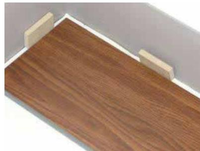
3. Krajnji spojevi dasaka u prvom redu sastavljaju se umetanjem strane s perom u stranu užlebljenja prethodne daske **pod prirodnim uglom**. Postepeno spuštajte dasku ravno dok se krajnji spoj ne zatvori, čime se obezbeđuje da daske budu savršeno poravnate. Postavite preostale cele daske u prvi red.
