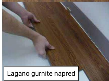
9. Nastavite da postavljate sleva nadesno održavajući nasumični izgled. Daske se mogu postavljati red po red ili obradom više redova metodom stepenica. Obavezno održavajte pravilan razmak kod zidova i vertikalnih prepreka.
