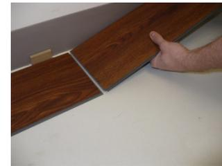
Mesurez la distance entre le mur et la surface de la dernière planche complète. Soustrayez 6,3 mm (1/4 po) de la mesure obtenue pour tenir compte du séparateur. Si la mesure obtenue est inférieure à 30,4 cm (12 po), longueur de la première planche de la rangée doit être taillée. Une planche plus longue pourra ainsi être
