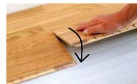
Il est impératif de respecter ce principe de montage pour que celui-ci soit aisé et soigné. N'oubliez pas de mettre des points de colle sur la périphérie de la surface avant l'installation des lames (comme représenté ci-dessous).
