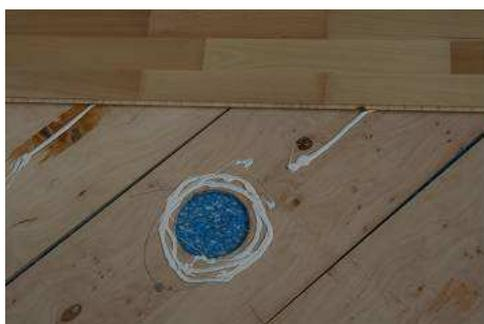
Avant de poser les lames de parquet - Appliquer de la colle tout autour du défonçage réalisé
