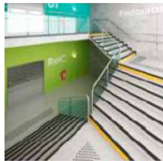
Taktila varningsytor i golvet indikerar var trappsteget börjar och slutar.
