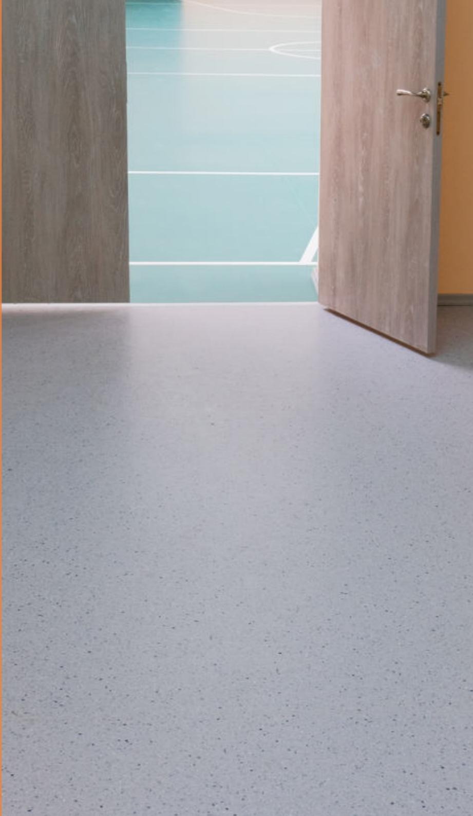
При профессиональном методе укладки швы соединяют горячей сваркой. Бесщелевое покрытие дольше служит, его легче убирать, а в щелях не скапливается грязь.
