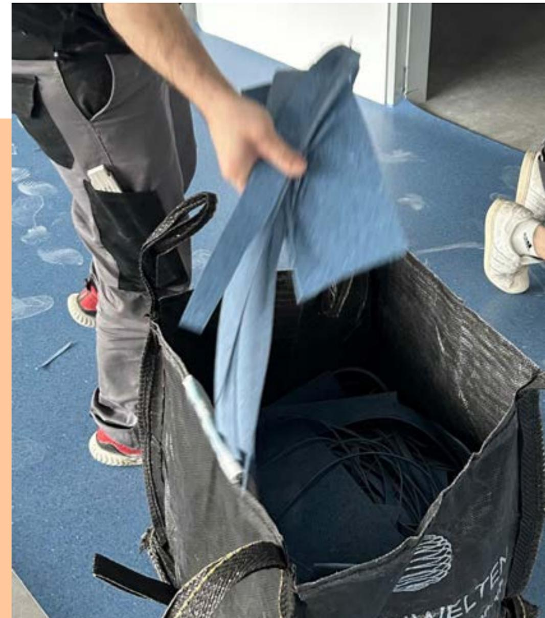
Verschnittreste aus Tarkett Bodenbelägen wurden direkt auf der Baustelle gesammelt und über das ReStart®-Programm von Tarkett zurückgeführt. Das Ergebnis: Der Verschnitt wird in unserem Werk recycelt und zu neuem hochwertigen Boden verarbeitet – der Materialkreislauf schließt sich, CO<sub>2</sub> bleibt gebunden und Recyclingmaterial wird gewonnen. Mehr erfahren zu:
